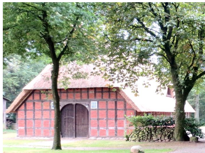
Bauernhaus von 1791 (Innengerüst von 1637)
